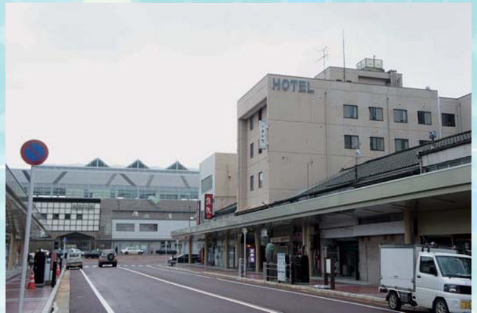
電線地中化によりスッキリした景観の新アーケード
