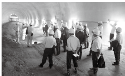
雨中バイパストンネル工事の様子
